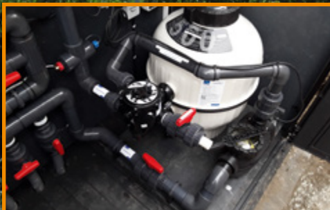
7. Aufstellen Filtertechnik
