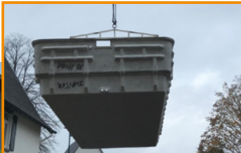
3. Einbringung des Beckens
