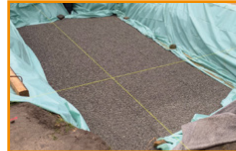
1. Splittfundament
